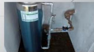
Figura 6. Filtro e Hidrômetro (matadouro) ago/2015
